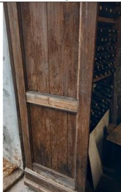
figura 5 Porta di una cantina in esterno, fessurata a causa delle variazioni di umidità
